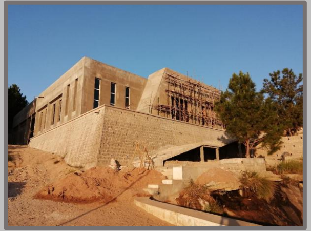
Construction d'une salle académique à Vohitsara
