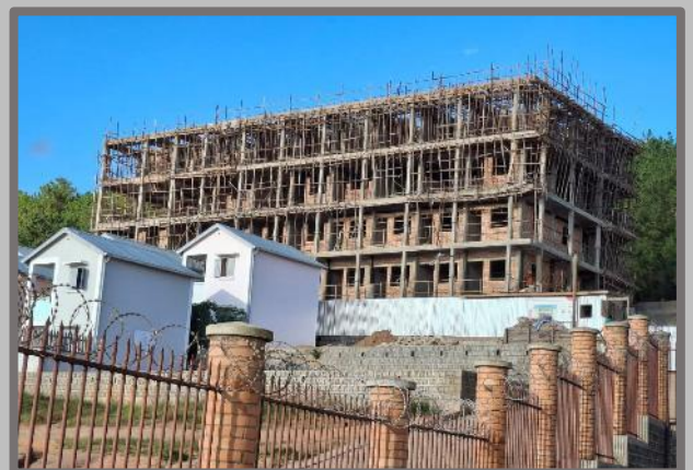
Construction d'une résidence pour les filles de l'université
