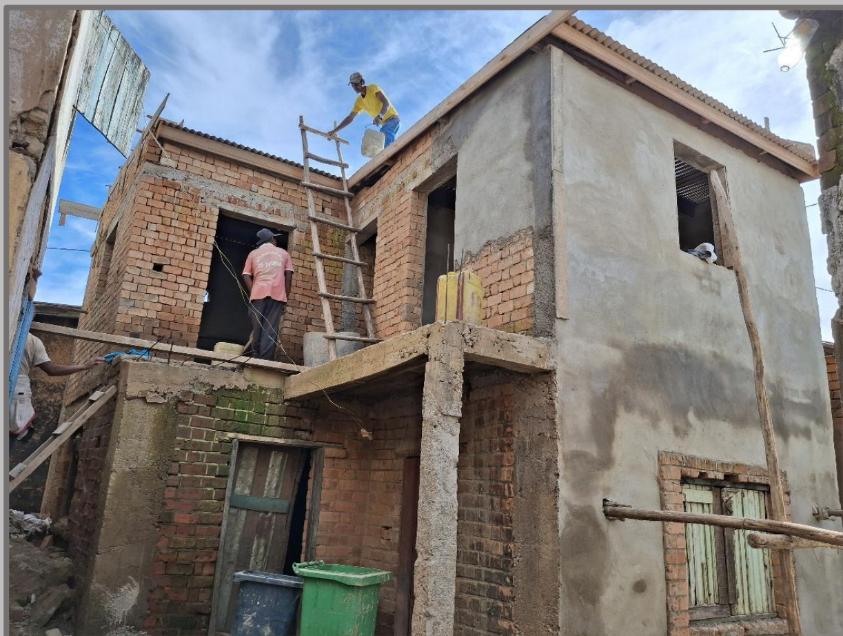
Le travail de construction
