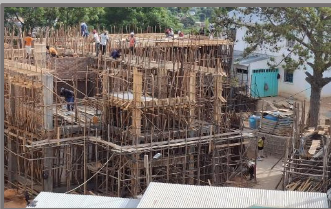
Construction d'une école primaire à Mahatsara
